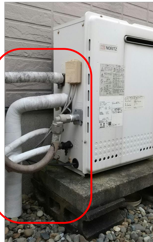
② 配管全体
