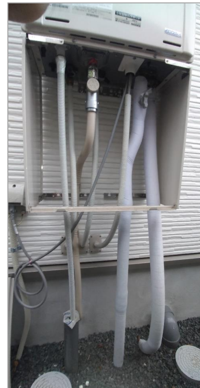
② 配管全体
